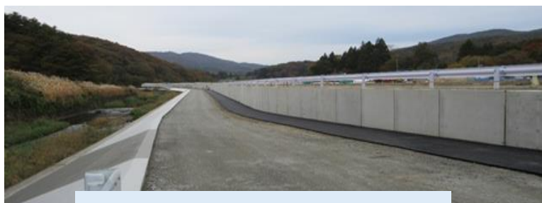
川沿いに2m高い垂直のコンクリート
