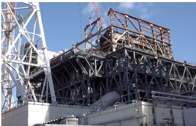
建屋全体を覆う大型カバーの建設が進む1号機
