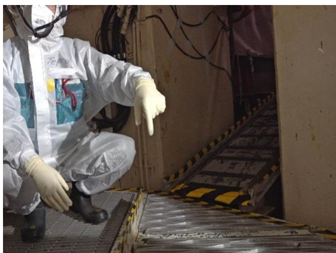
「X-6」と書かれた小さな貫通口（写真上）から ①棒状の装置を差し込み ②土台の開口部（写真中）を抜けて、圧力容器下に入り ③損傷してできたすき間から、指さす方向に小型のデブリ採取器具を垂らした（写真下） （近い構造の5号機にて筆者撮影）
